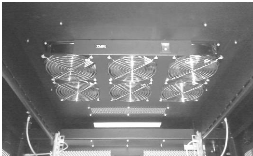
Установленный вентиляторный блок TLK-FAN6-BK
