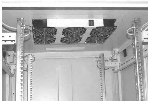
Установленный вентиляторный блок TLK-FAN6-GY в
